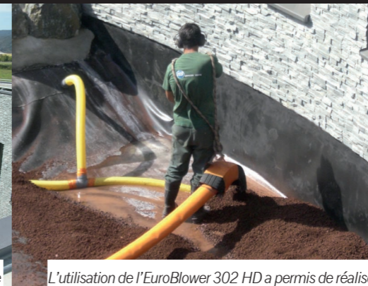
L'utilisation de l'EuroBlower 302 HD a permis de réaliser les risbermes pour plantations sur les rives d'un bassin enclavé dans un semi patio en apportant 75 m 3 de pouzzolane en 6 heures de travail effectif seulement.
