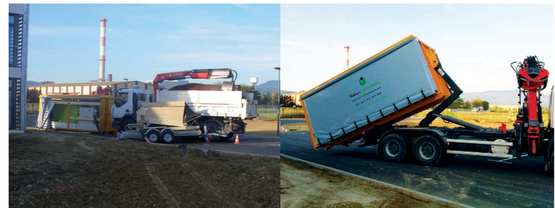
Préparation et mise en place de l'unité de soufflage EuroBlower 302 HD
