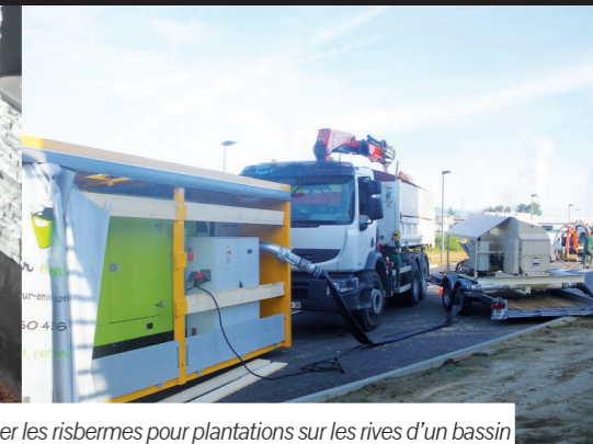
L'utilisation de l'EuroBlower 302 HD a permis de réaliser les risbermes pour plantations sur les rives d'un bassin enclavé dans un semi patio en apportant 75 m 3 de pouzzolane en 6 heures de travail effectif seulement.
